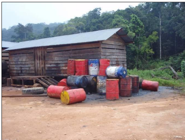
Photo 3: huiles usagées se répandant dans les sols et le cours d'eau en contrebas de la zone de stockage
