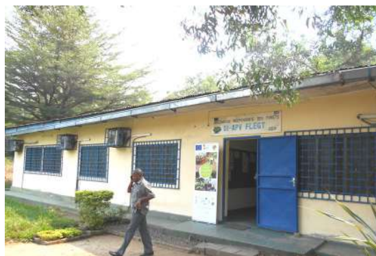
Bâtiment abritant les locaux de l'OI FLEGT
