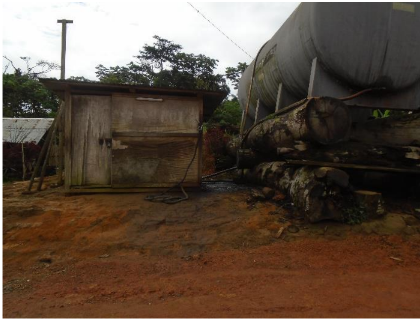
Photo 7: Epanchement au sol des déchets liquides (carburant), sans système de traitement
