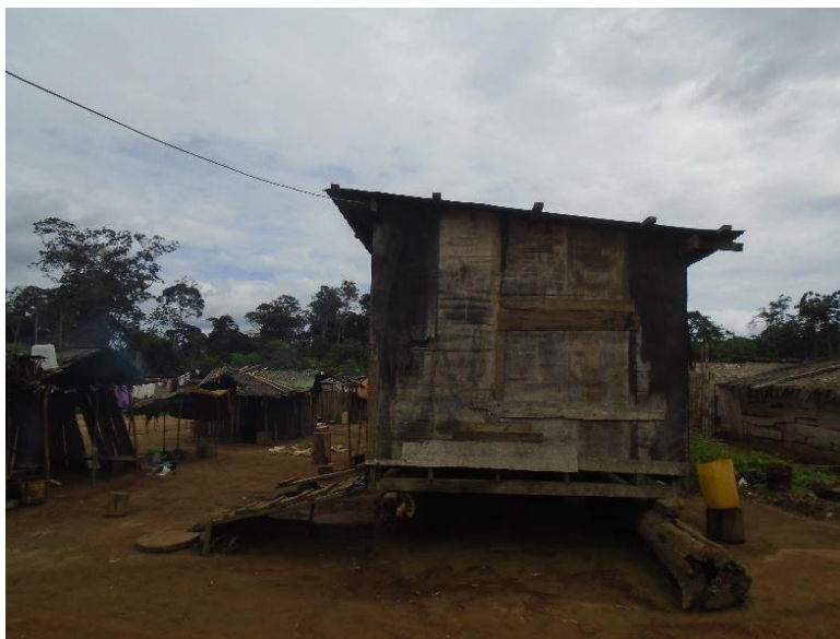
Photo 5: Logement des travailleurs
