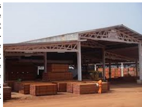
Usine de sillage de la société MOKABI SA
